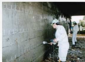
鋼材腐食診断 (自然電位法)
