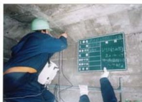
ひび割れ深さ・厚さ測定 (超音波法)
